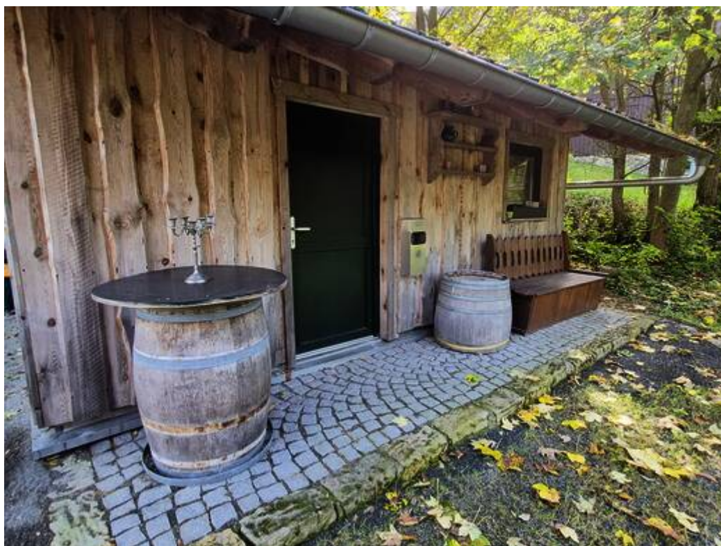
Seiteneingang zur Garage
