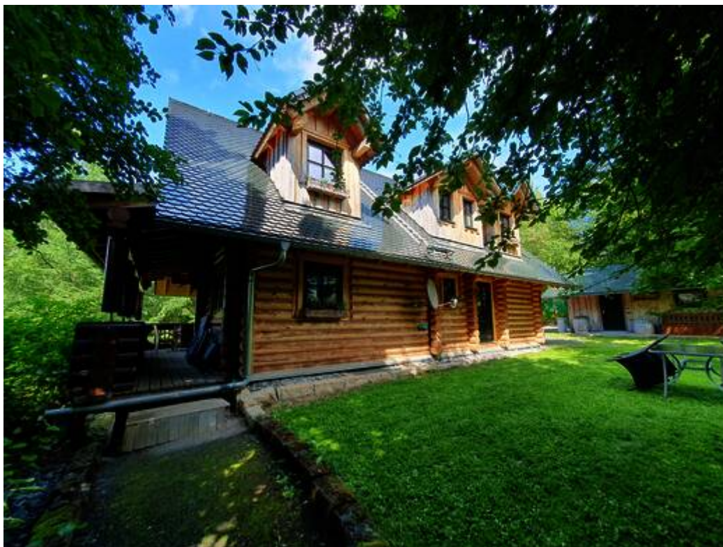
Seitenansicht mit Terrassenzugang
