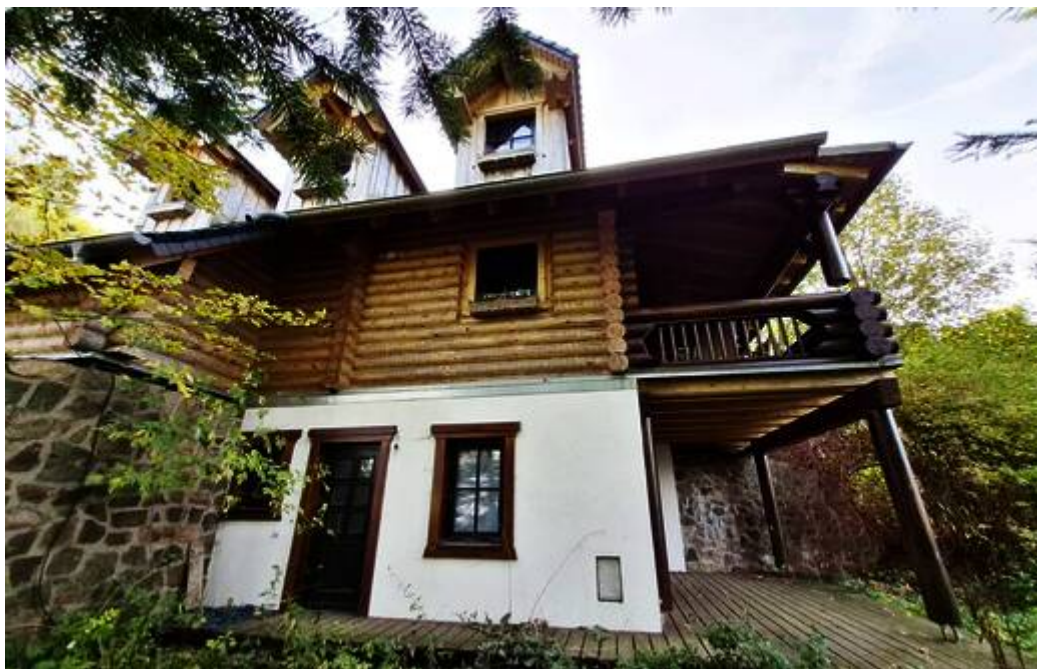
Einliegerwohnung im Untergeschoss
