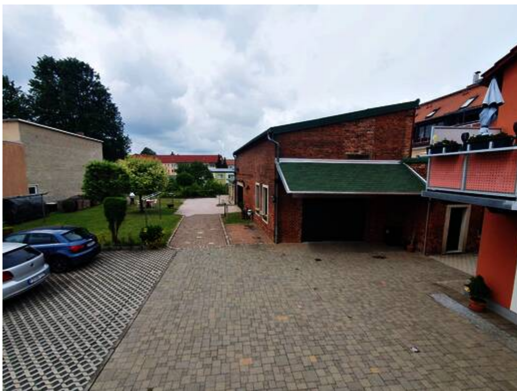
Parkplätze, Gartennutzung u. Nebengelass
