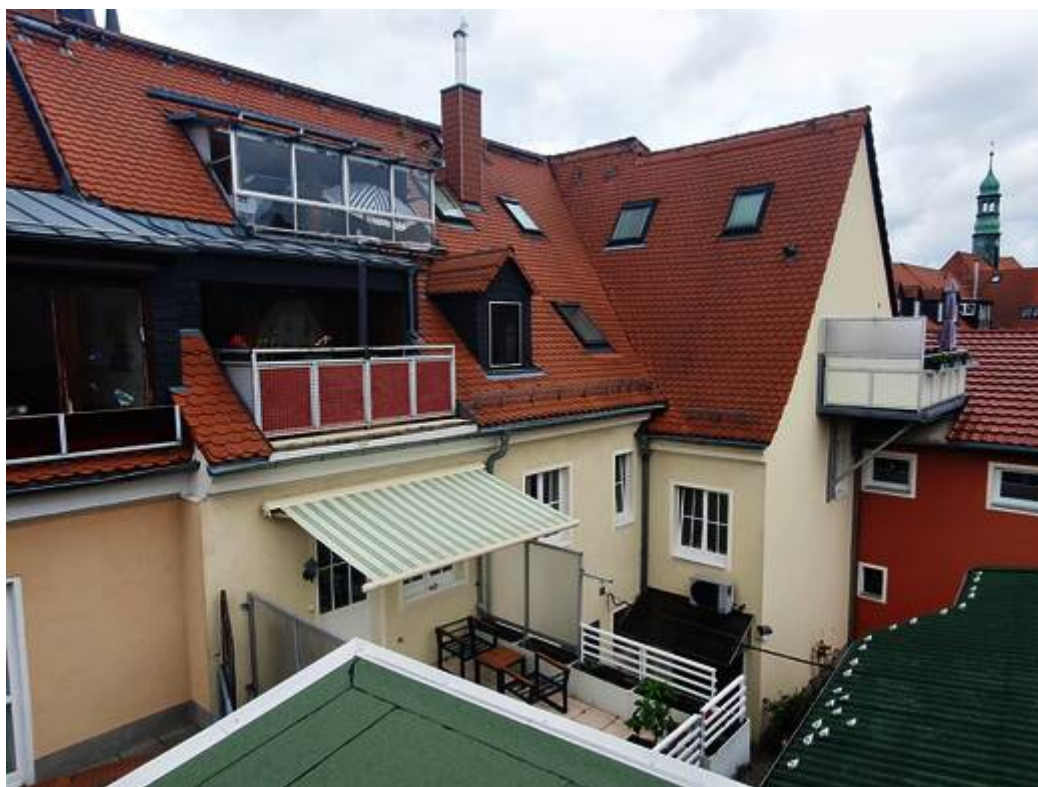
Rückansicht / Innenhof Objekt A
