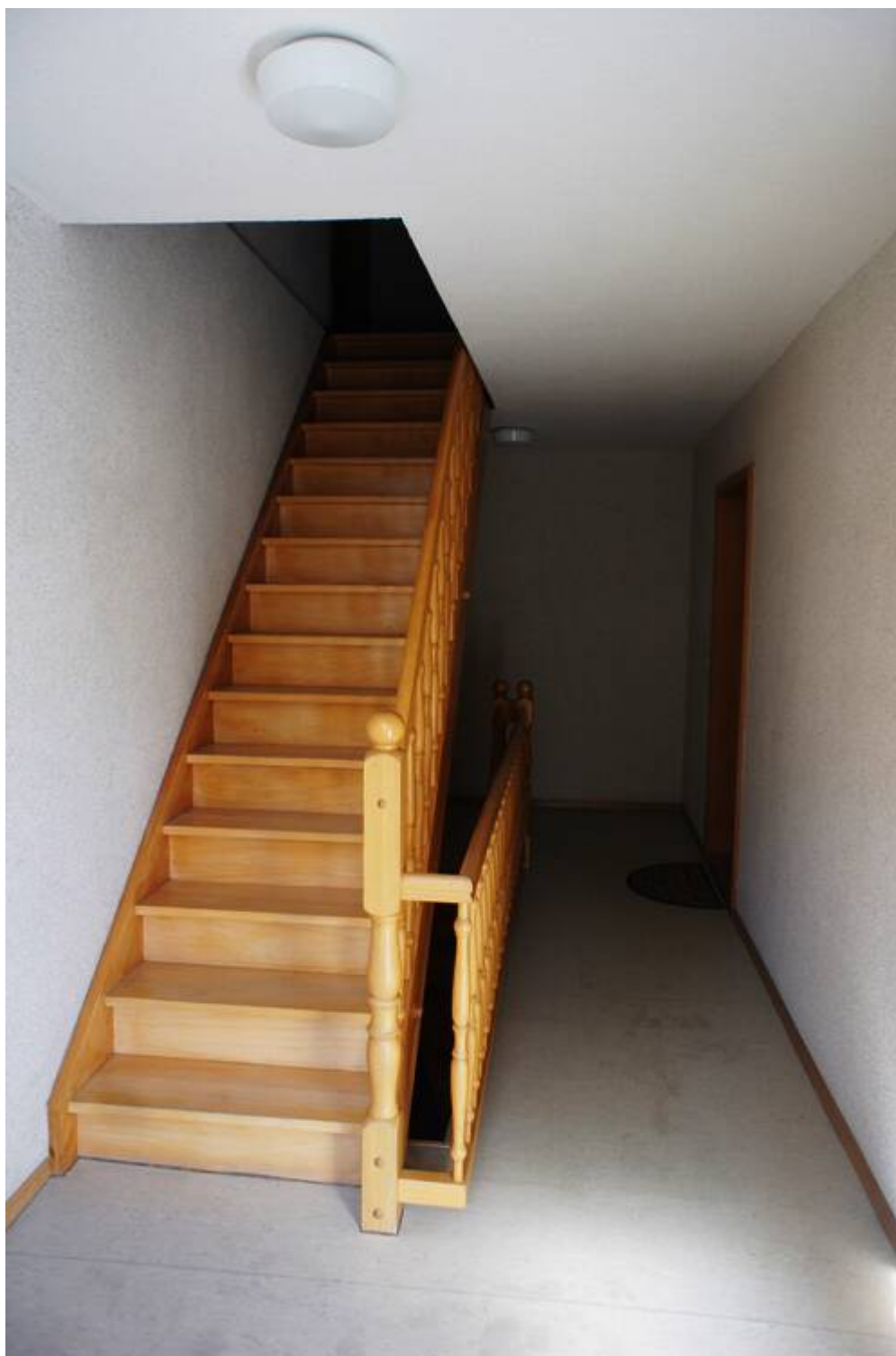
Treppenhaus Haus F
