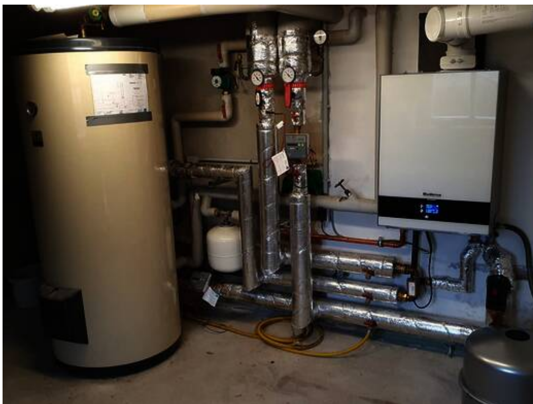
Heizung u. Warmwasser / mehrfach erneuert
