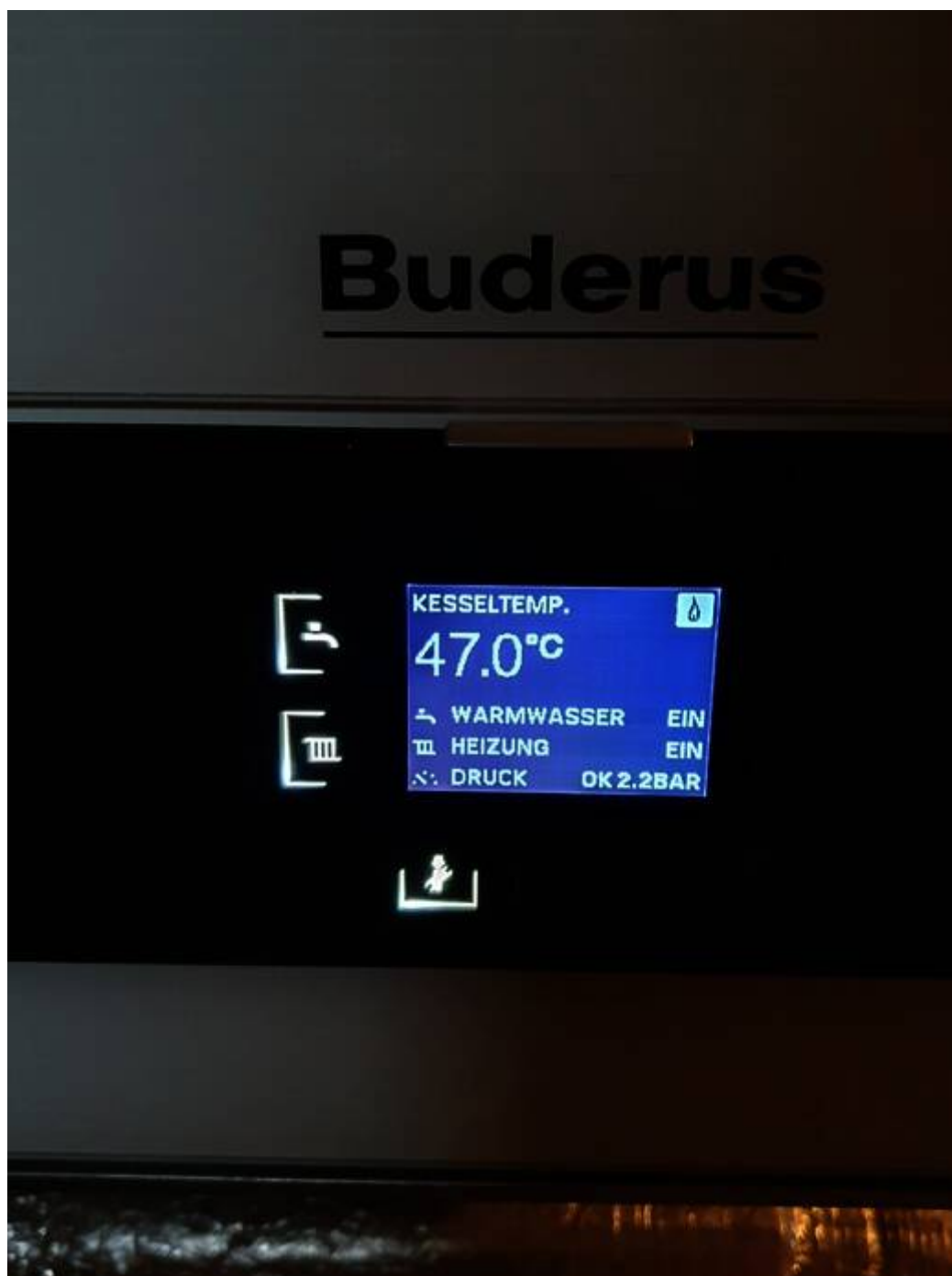
Brennwerttherme mehrfach erneuert
