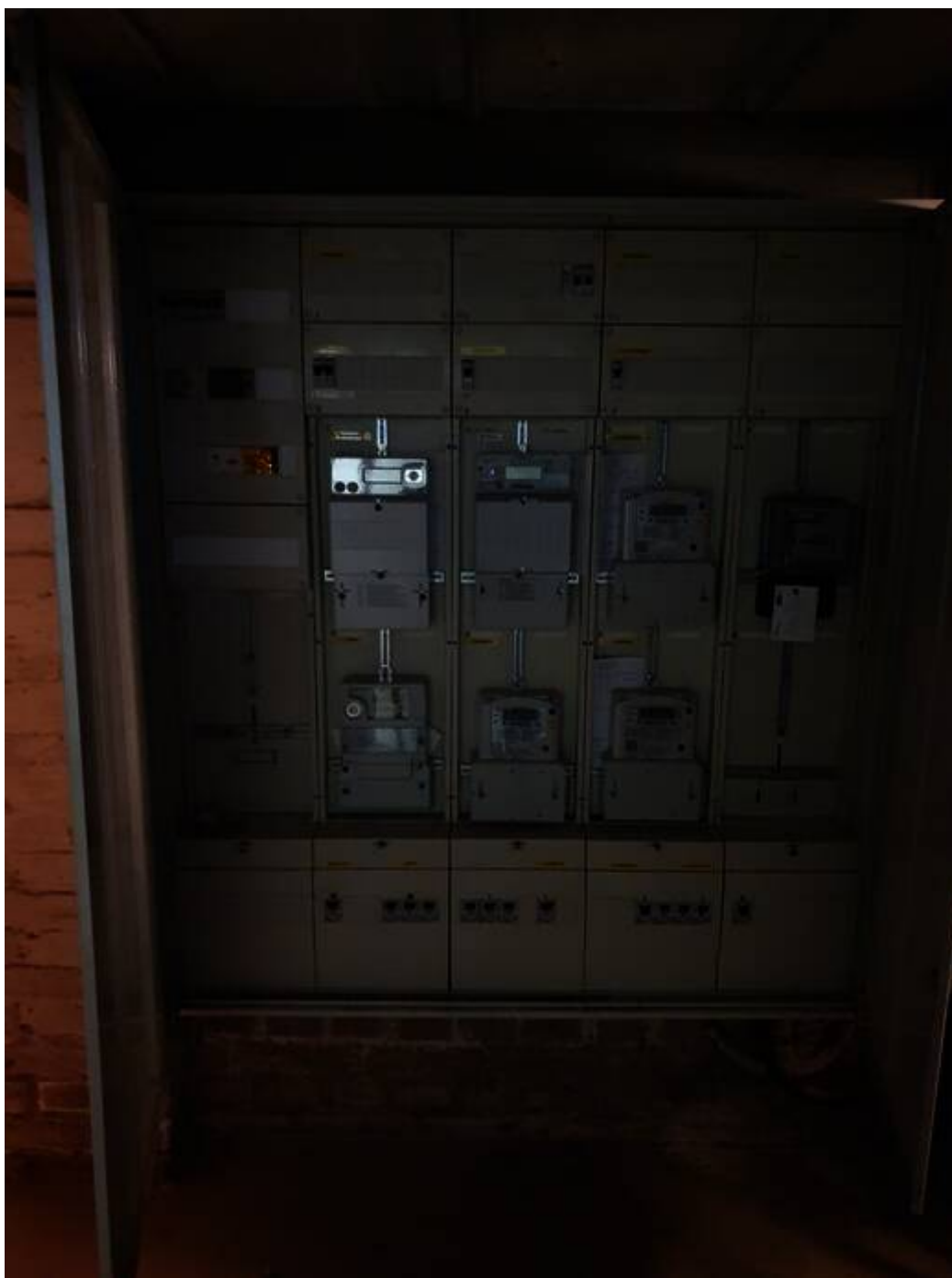
Elektrozähler mehrfach erneuert
