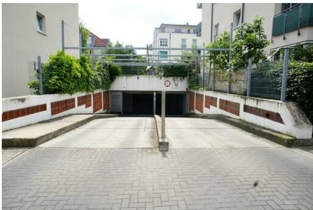
Einfahrt zur Tiefgarage
